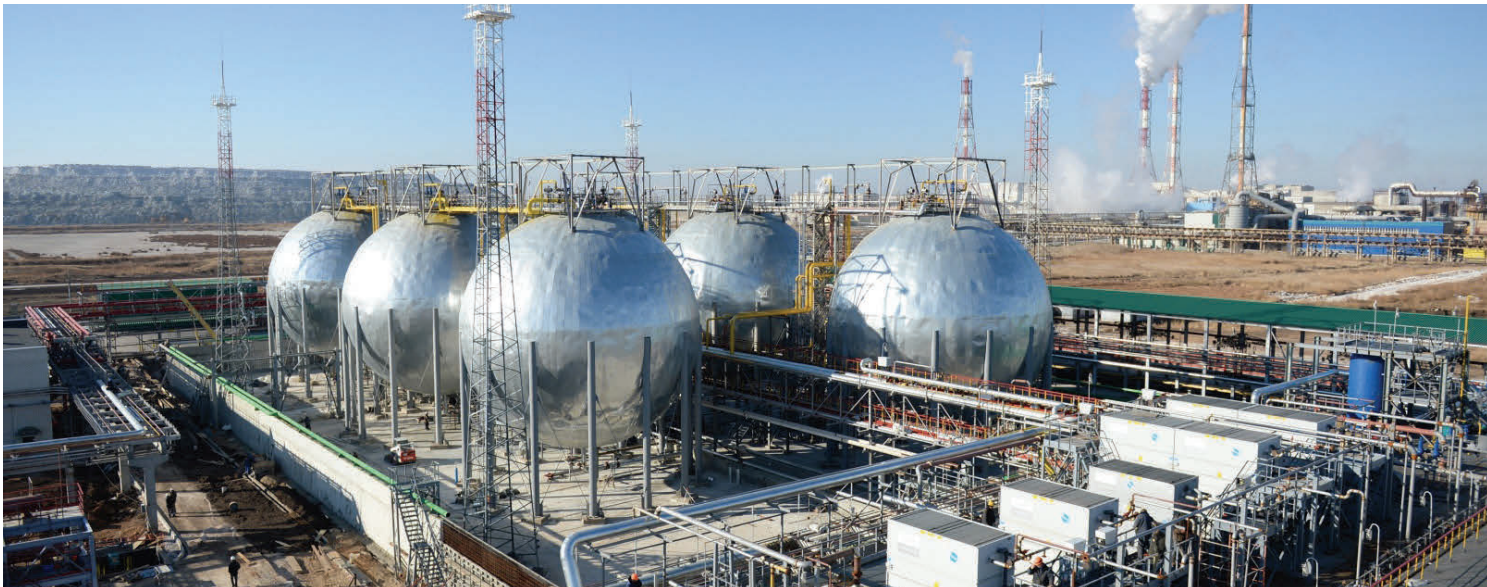
Монтаж шаровых резервуаров 3000 м 3
