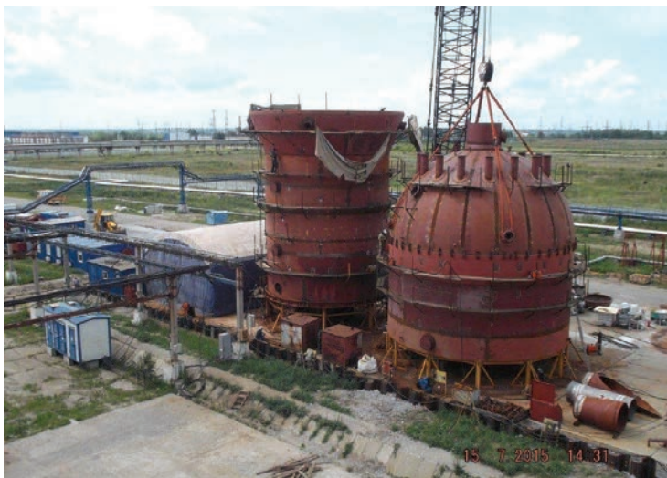
Монтаж оборудования реакторно-регенераторного блока секции каталитического крекинга на Омском НПЗ
