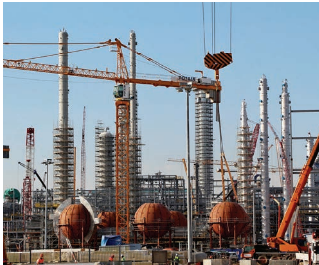
Промежуточный парк хранения бутадиена Шаровые резервуары 600 м 3
