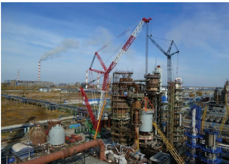
Монтаж оборудования реакторно-регенераторного блока секции каталитического крекинга на Омском НПЗ
