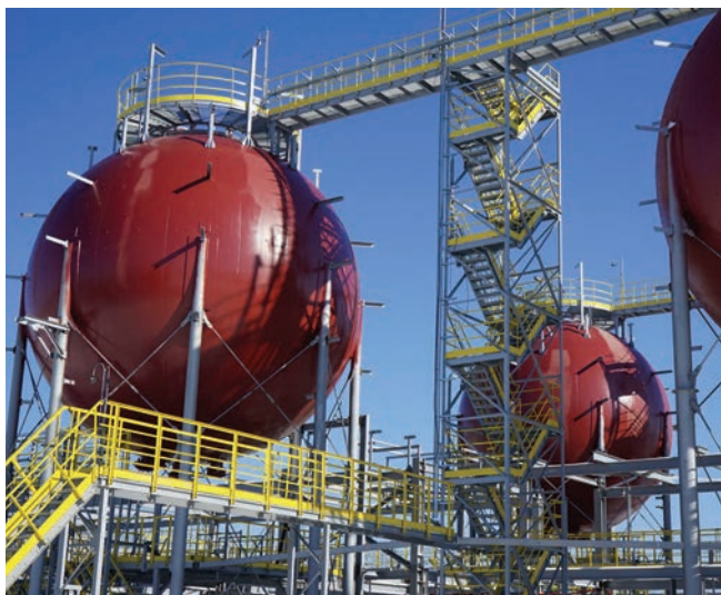
Парк хранения ШФЛУ. Шаровые резервуары 600 м 3
