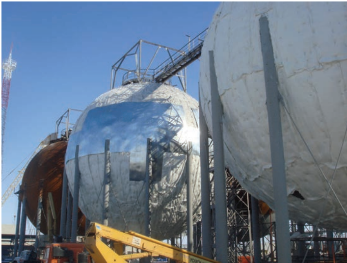
Монтаж шаровых резервуаров 3000 м 3
