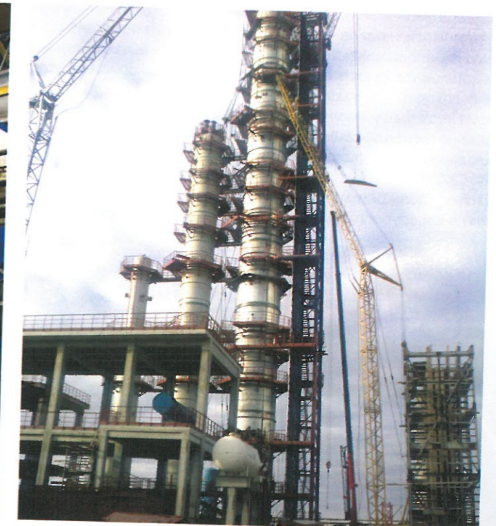
Монтаж колонного оборудования в ОАО «Газпромнефть-ОНПЗ»
