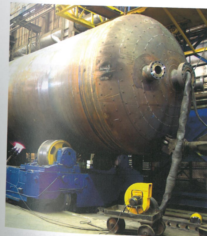
Изготовление реактора гидроочистки в цехе №40
