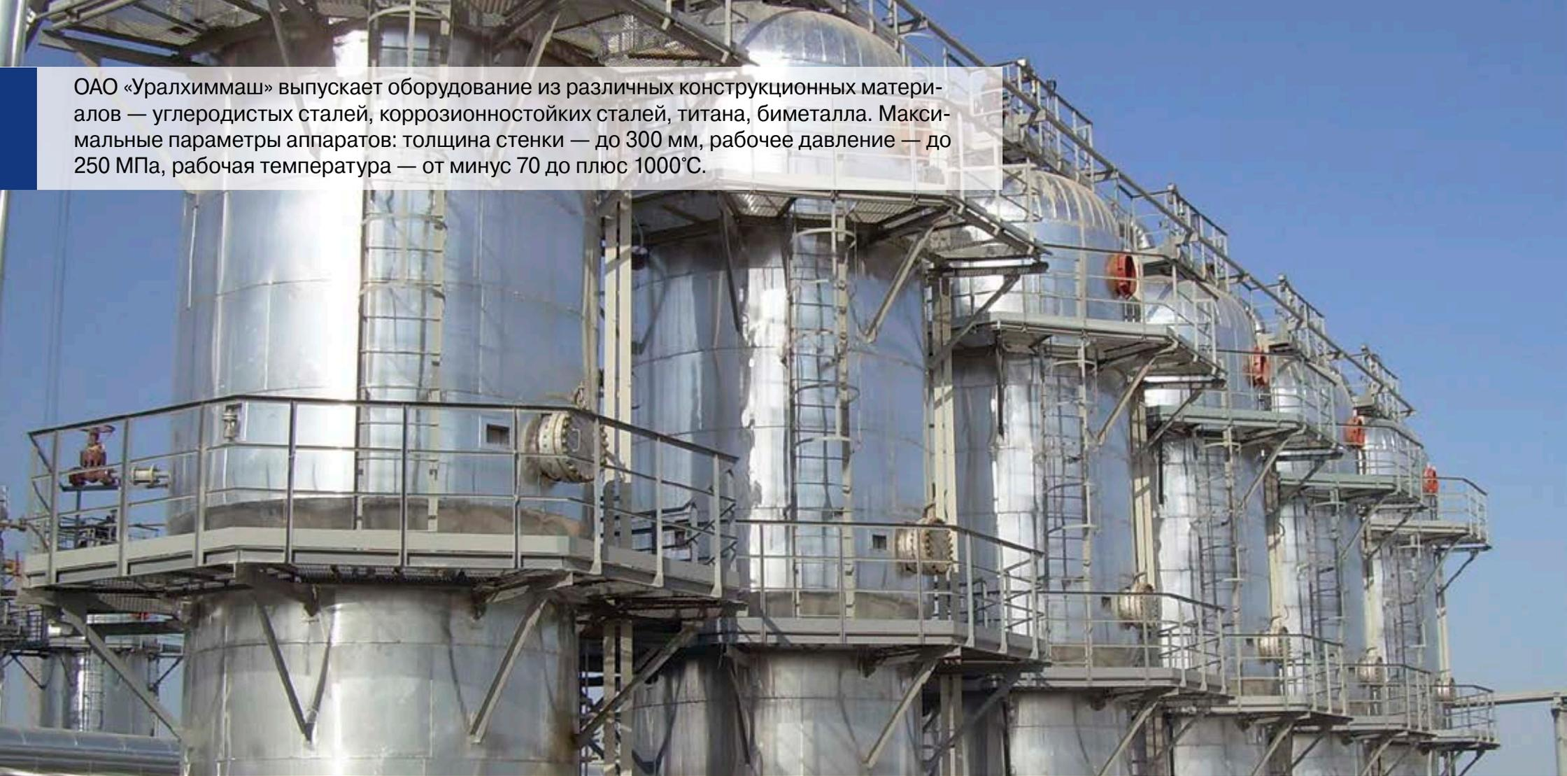
ОАО «Уралхиммаш» выпускает оборудование из различных конструкционных материалов — углеродистых сталей, коррозионностойких сталей, титана, биметалла. Максимальные параметры аппаратов: толщина стенки — до 300 мм, рабочее давление — до 250 МПа, рабочая температура — от минус 70 до плюс 1000°С.
