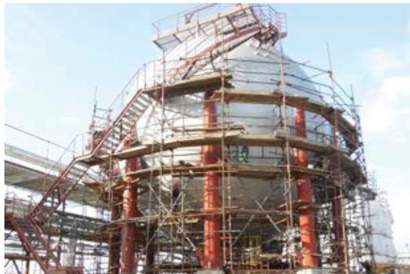
Шаровой резервуар комплектуется внутренней смотровой лестницей, верхней площадкой обслуживания, переходными мостами, шахтной лестницей, штуцерами, люками и др. Монтаж резервуаров производится подразделениями ОАО «Уралхиммаш».
